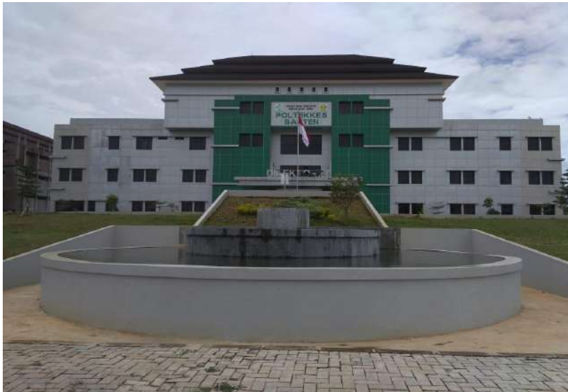
Gambar: 1 Gedung Direktorat Poltekkes Kemenkes Banten
