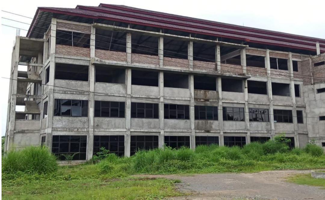
Gambar: 4 Gedung Kampus Serang untuk kelas dan Laboratorium
